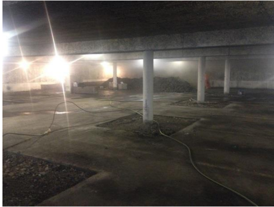
Parkeringshuset på Sotingeplan där mätningarna utfördes vid renoveringsarbetet.
